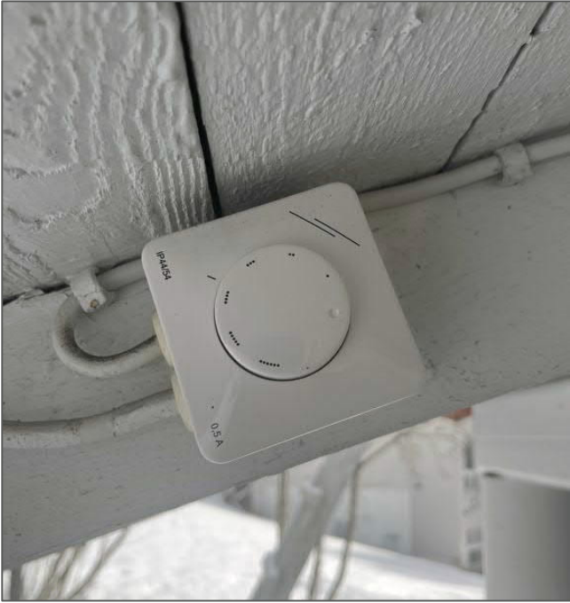
Kuva 1. Radonimurin virtakytkin ja tehosäädin.
