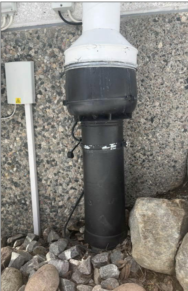
Kuva 2. Salaojaputkistoon kytketty raadonimuri.
